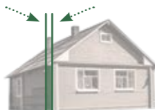
Расстояние между стеной дома и концом кровли от 80 см
